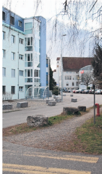
An der Alten Gasse muss ein Trottoir erstellt werden. MARCEL SIEGRIST
